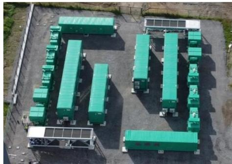
**Abb. 2** Der Prüfstand für die Offshore-Windenergieanlagen ist in der Lage, auch sehr große Anlagen bis zu einer Leistung von 28 Megavoltampere (MVA) zu testen.
