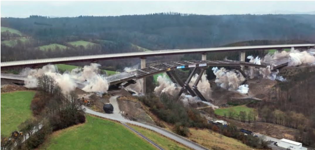
Am 6. Februar fiel die marode, 500 Meter lange und 70 Meter hohe Rinsdorf-Talbrücke an der A45 exakt geplant in sich zusammen – Zentimeterarbeit. Direkt daneben stand schon das erste Teilstück des Neubaus, das auf keinen Fall beschädigt werden durfte.
